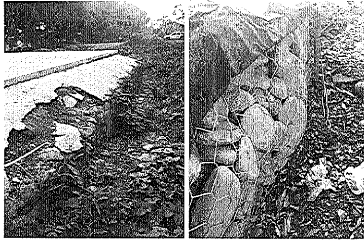
Figuras 3 y 4: Mala construcción del Subsuelo y Mala calidad de los Gaviones
