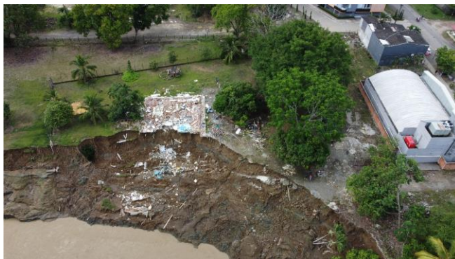
Figura 213. Socavación en el río Apartadó
