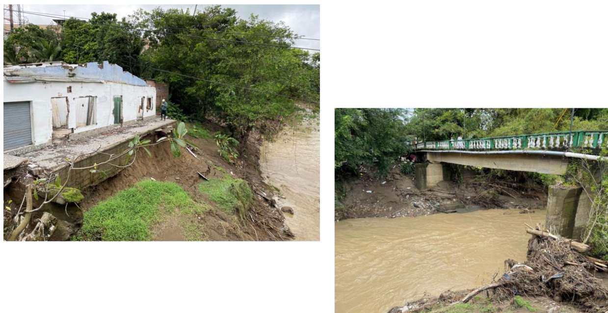
Figura 13. Socavación en el sector Puente El Vélez de la cabecera municipal, vivienda evacuada.
