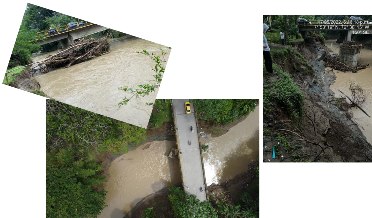
Figura 12. Material transportado por inundaciones en mayo de 2022 y efectos de socavación en el sector Puente La Libertad de la cabecera municipal.
